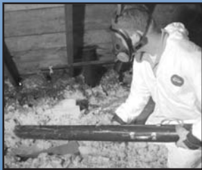
Retrait d'isolant contaminé de fientes de chauve-souris.
