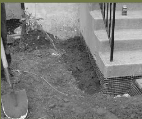
Tranchée et grillage empêchent les mouffettes de retourner à leur gîte.
